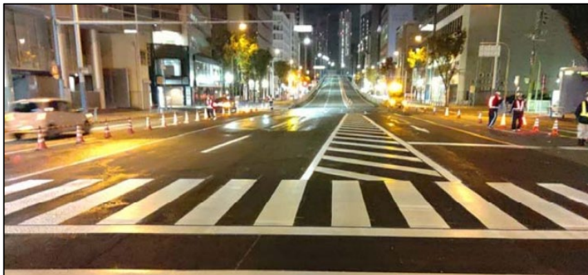
舗装及び区画線の復旧（施工後）
