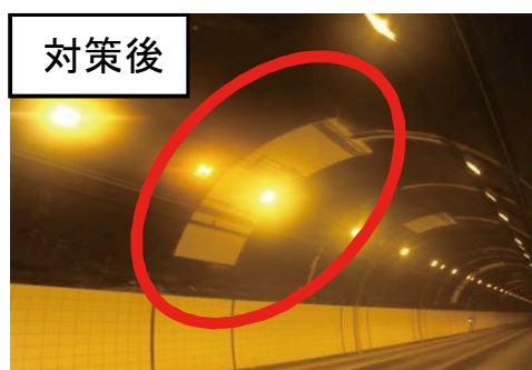
断面修復・剥落防止
