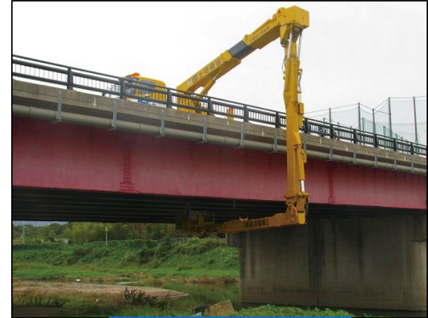
定期点検 (橋梁)
