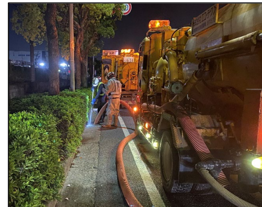
管渠（かんきょ）清掃
