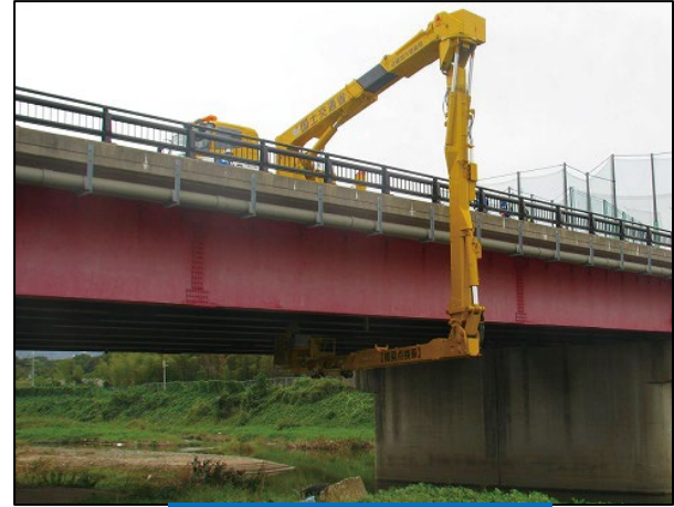
定期点検 (橋梁)
