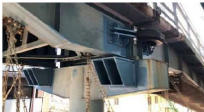
写真⑤ 落橋防止構造設置 安治川大橋
