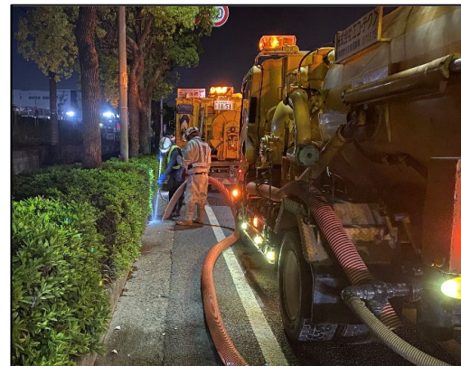
管渠（かんきょ）清掃
