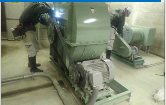
換気ファンベルト劣化点検
