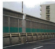
新型遮音壁 (西淀川区内)
