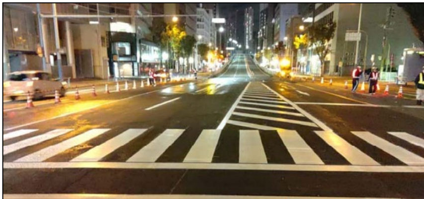
舗装及び区画線の復旧（施工後）
