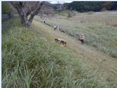
肩掛け式箇所の除草（法面）②
