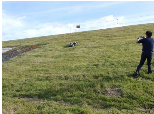
福井市船橋新町地先（馬渡川樋門付近） 試行状況
