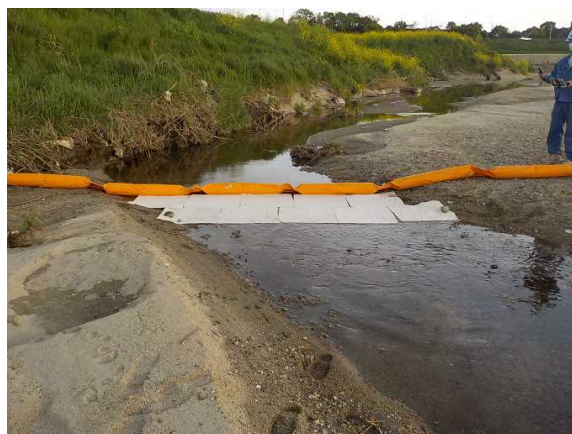
②大和川本川合流点付近にオイルフェンス設置
