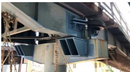
落橋防止構造設置 安治川大橋
