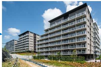
建替後の公営住宅（第1期）
