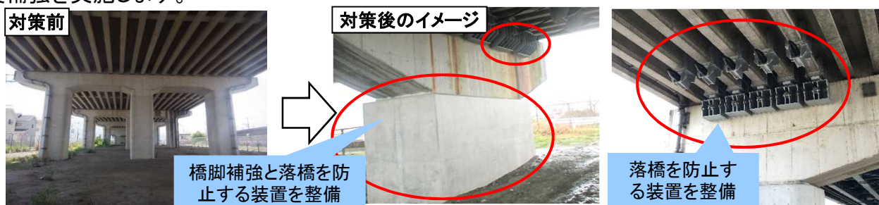
奈良県 165号 新庄高架橋
