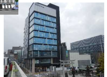
建替工事中の建築物 (R4年3月現在)
