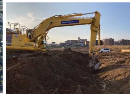
桂川河道掘削状況
