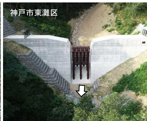
ざふくがはら 座福ヶ原第二砂防堰堤(神戸市)
