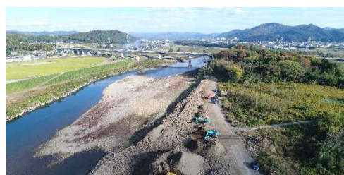
由良川中流域 河道掘削状況
