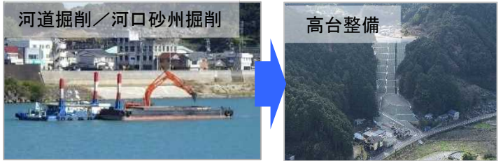
掘削土砂の有効活用
