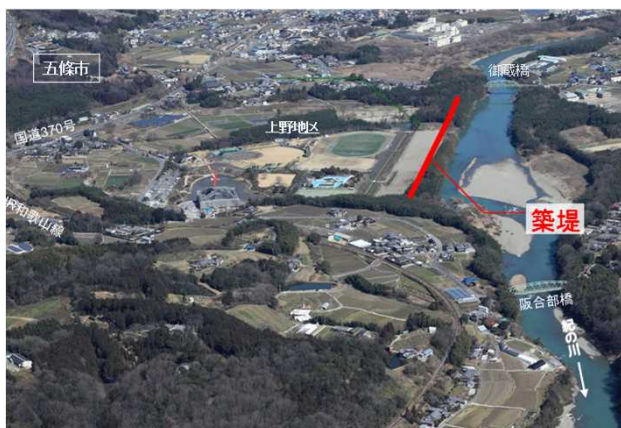
上野地区 無堤部解消（築堤整備）
