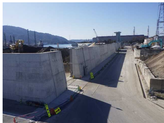
護岸の整備状況
