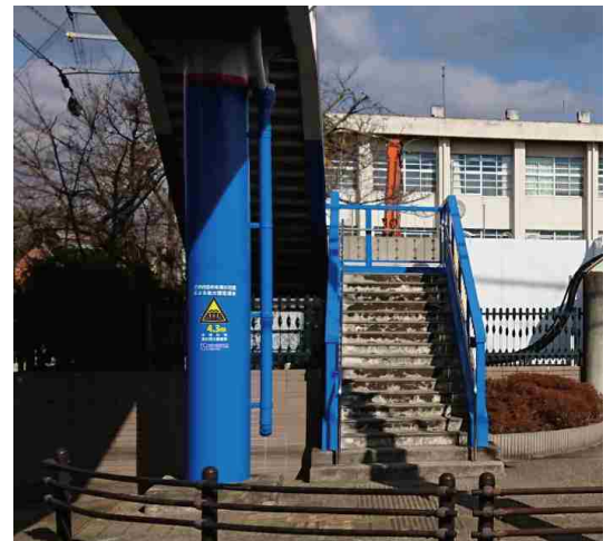
歩道橋の設置例
