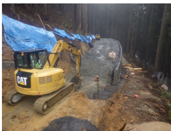
千代谷2工区施工状況 (R1.12)
