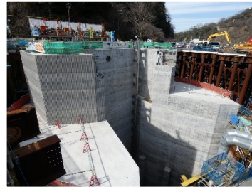
流入部施工状況 (R2.3)
