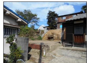
周辺住環境に悪影響を及ぼしている老朽化した空き家と除却後の様子
