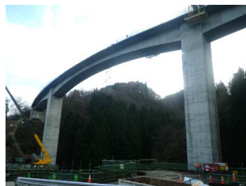
8号橋施工状況 (R1.12)
