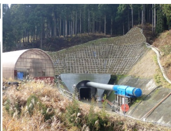
水海川導水トンネル吐口部 施工状況 (R1.12)
