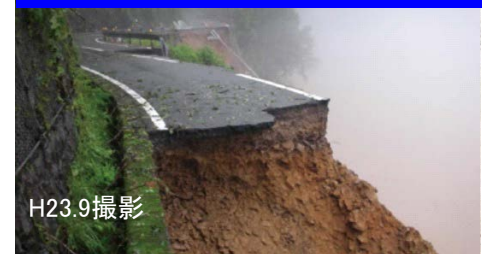
国道168号現道の崩落状況
