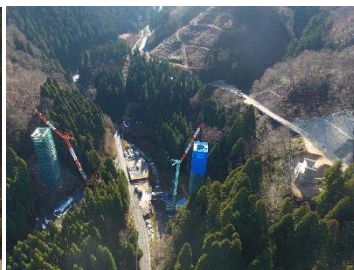
11号橋施工状況 (R1.12)
