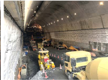
減勢池部施工状況 (R2.3)
