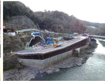
吐口部施工状況 (R2.3)
