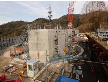
ゲート室部施工状況 (R2.3)
