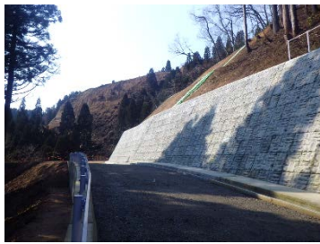
4号工事用道路施工状況 (H31.3)
