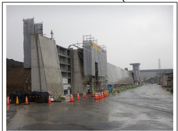
護岸の整備状況
