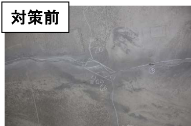
対策前 鉄筋腐食、ひび割れ
