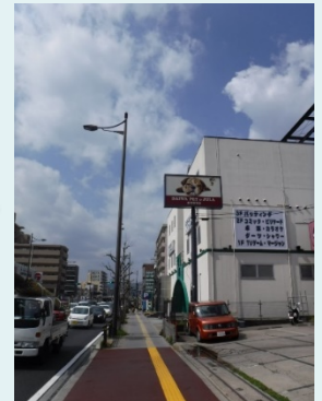
整備後（抜柱後）
