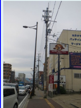
整備前（抜柱前）
