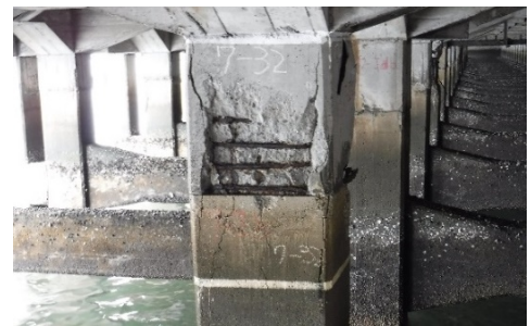
【脚柱部のコンクリート剥離、鉄筋腐食】
