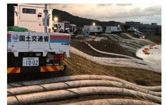
排水ポンプ車による緊急排水
