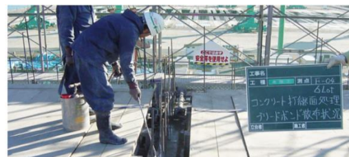
写真-2 施工状況 (KT-110001-VE)
