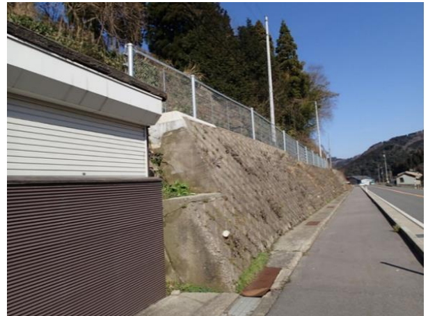
写真-4 完成写真
