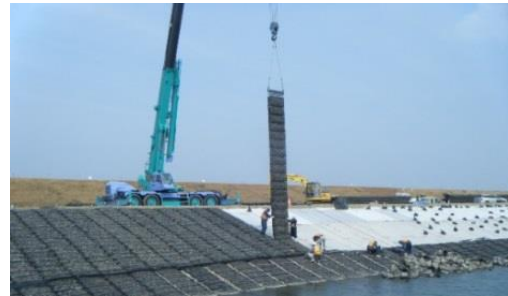
写真-6 施工状況
