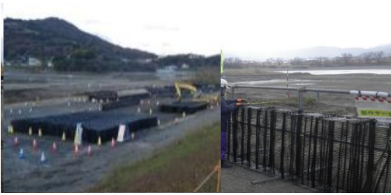
写真-4 組立て状況
