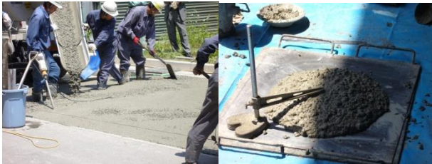
写-7 施工状況(左)とスランプフロー(右)
