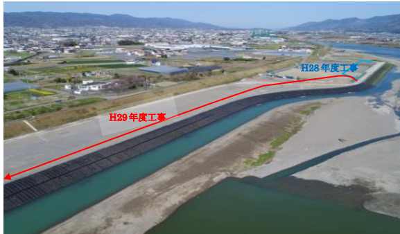
写真-5 完成状況
