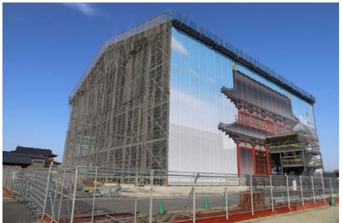
南門素屋根・見学デッキ
