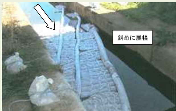
■現場での吸着式オイルフェンス設置例
