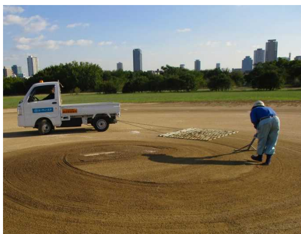
運動施設の復旧状況(西中島地区)
