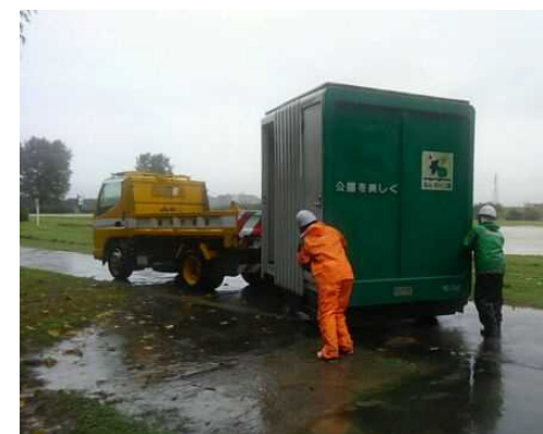
公園施設撤去風景(大山崎地区)
