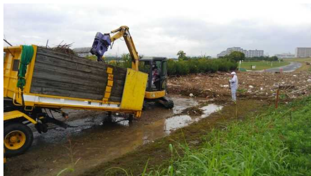
ゴミ・ヘドロ等の撤去状況(太子橋地区)
