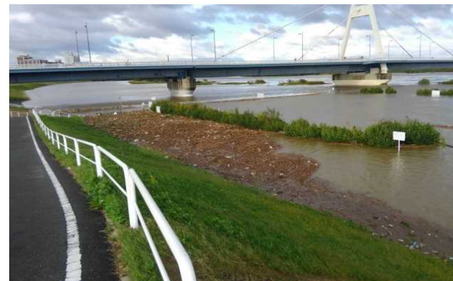
水位上昇し、公園が冠水(太子橋地区)
