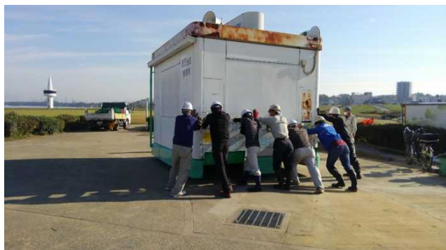
管理所の復旧状況(枚方地区)
