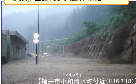
写真① 国道158号 冠水・崩落
