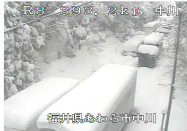
①(2/7 10時頃)2車線区間の滞留状況
