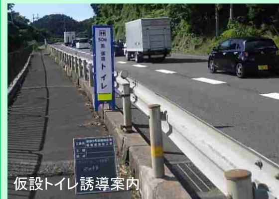
仮設トイレ誘導案内
