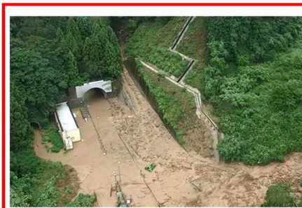
北陸自動車道 被災状況
