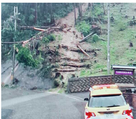
▲国道371号(和歌山県橋本市柱本)で発生した崩土の状況
