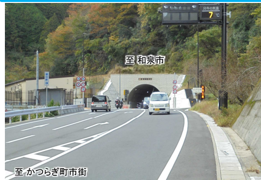
【写真②】鍋谷トンネル南側坑口付近
