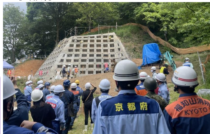
土砂災害対策事業実施箇所（福知山市大江町三河地内）
