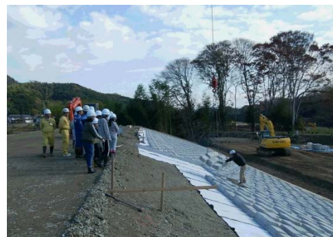
▲実際の施工手順などを施工業者から説明（左：盛土工、右：護岸工）
