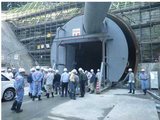
【導水トンネル工事現場】
