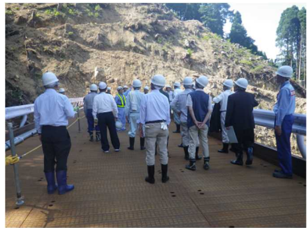
【1号工事用道路工事現場】
