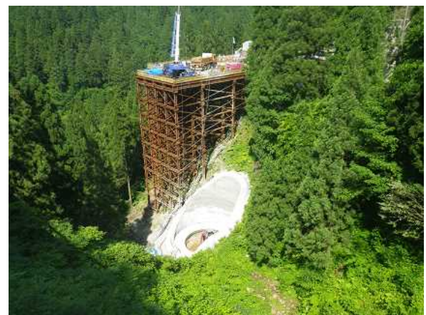
【付替県道7号橋工事現場】
