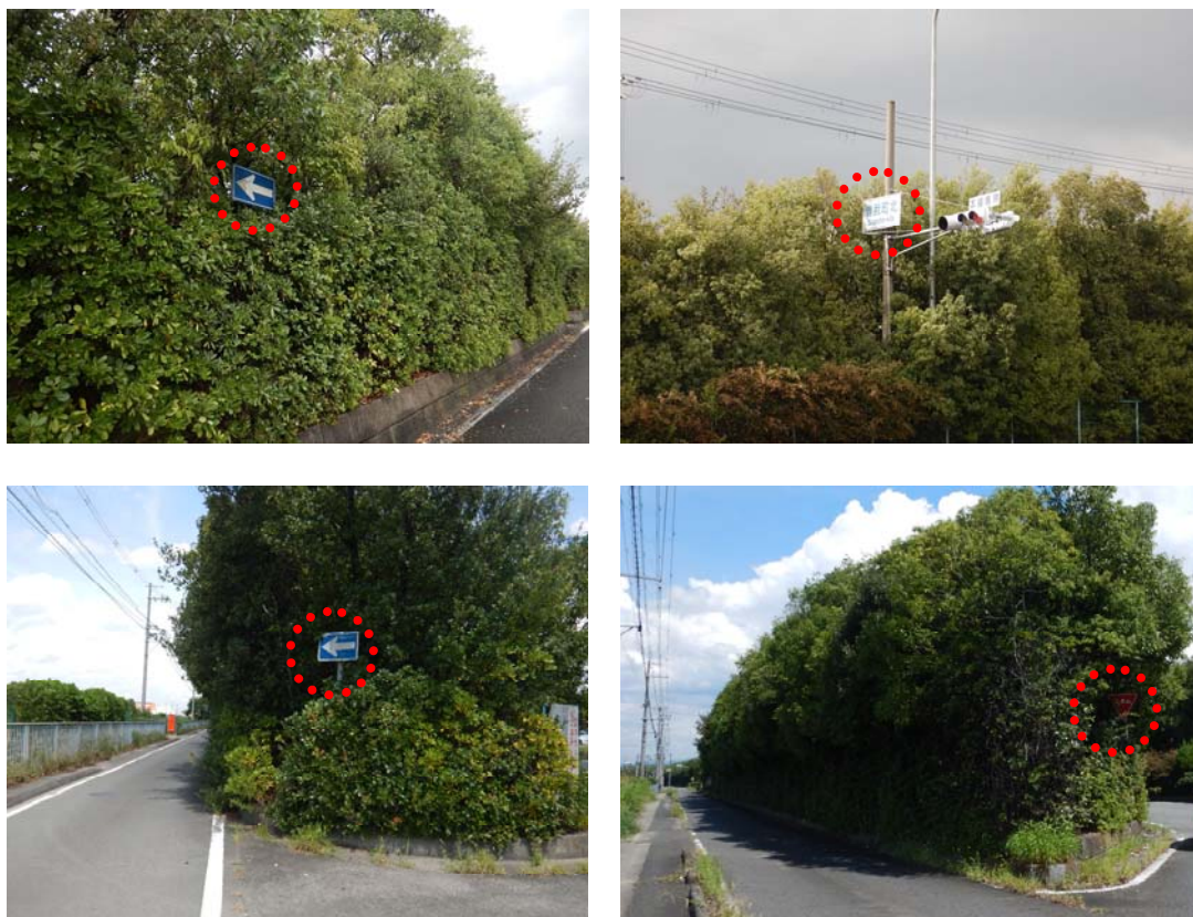
図 樹木による標識の視認性低下状況
