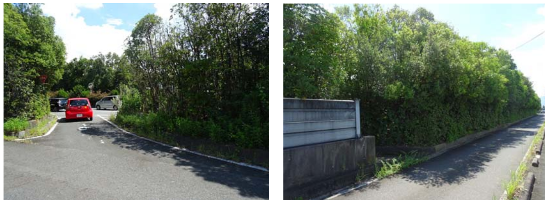
写真 樹木による視距不良状況
