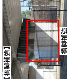
落橋防止構造
