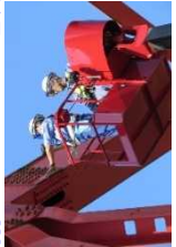
直轄診断(三島大橋)
