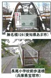
通行止め橋梁
