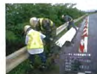
〈防護柵の取替〉
