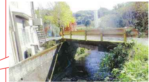
老朽橋の撤去
