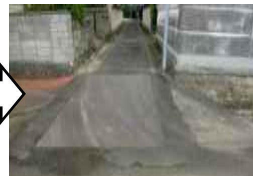
■対策後(覆工板設置)
