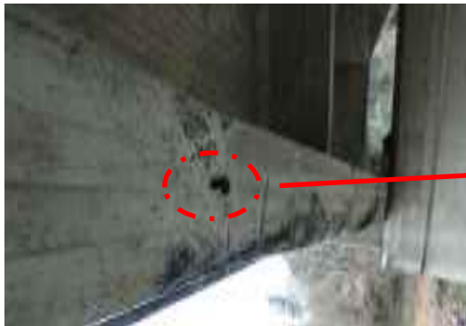
■石桁破断状況
