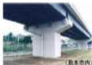
写真-3 国道3号 跨線部
