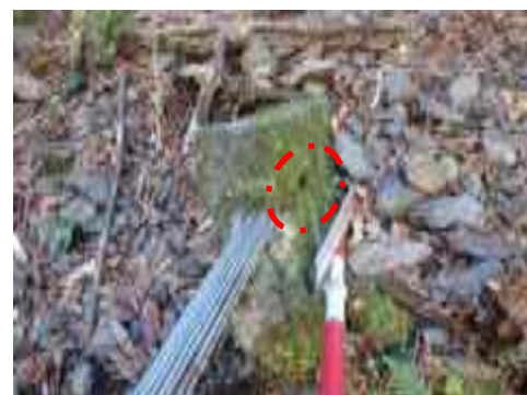
■主索アンカ一定着部Co剥離状況
