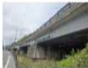
写真-4 阿蘇口大橋 (国道57号)
