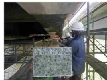
修繕の様子(断面修復)
