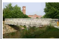
FRP 歩道橋(米国)
