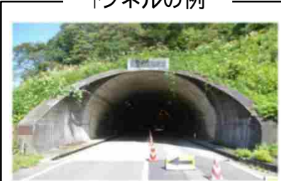
トンネルの例
