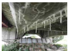
主桁のひびわれ
