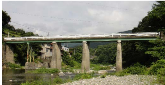
<御鉾橋の状況>
