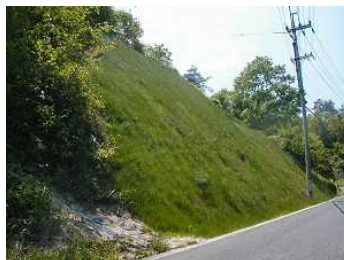
切土(法面保護)
