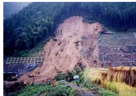
強風化・土砂化斜面での崩壊例
