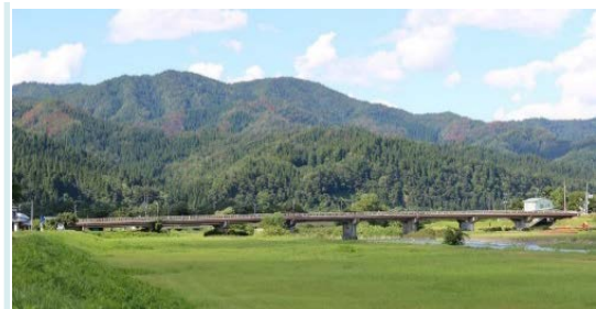
<万石橋の状況>
