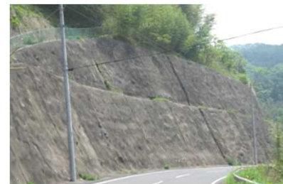
モルタル吹付
