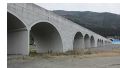
アーチカルバート
