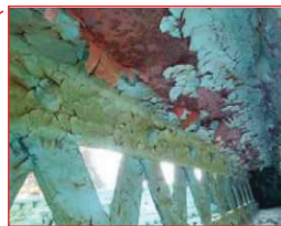
鋼材の腐食
