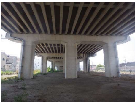
橋梁 耐震補強前
