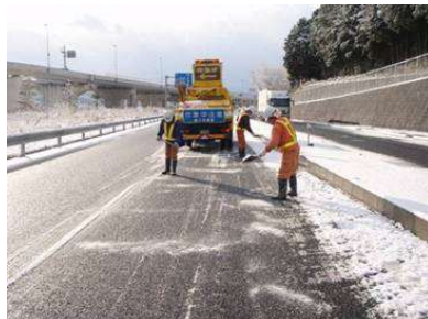
凍結防止剤散布状況
