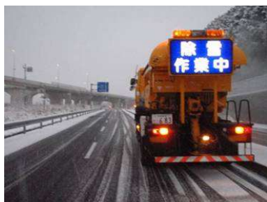
凍結防止剤散布状況
