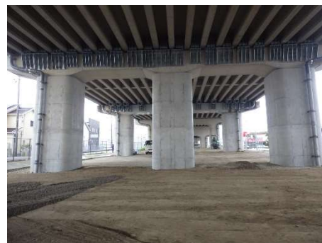
橋梁 耐震補強後
