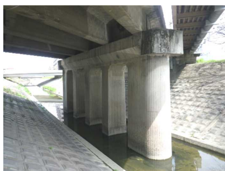
橋梁 耐震補強前
