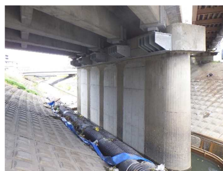
橋梁 耐震補強後
