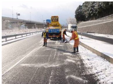
凍結防止剤散布状況
