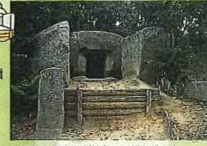
北河内地域でただひとつ、横口式石室をもつ「石の宝殿古墳」(国指定史跡(豊川市打上))
