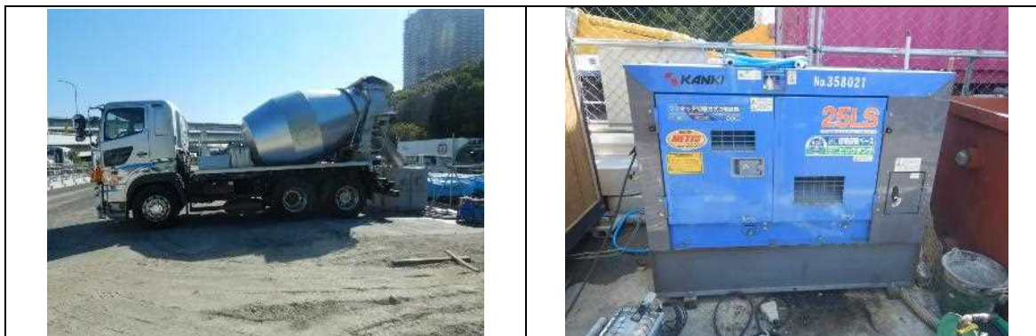
図 5-3 建設機械の稼働状況
