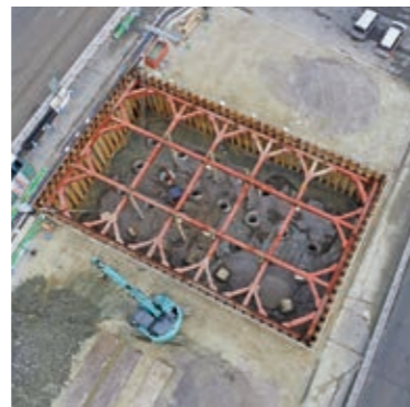
橋脚の基礎杭施工状況(2021年1月中旬時点)
