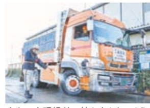
土を工事現場外に持ち出さないよう、トラックのタイヤを洗浄
