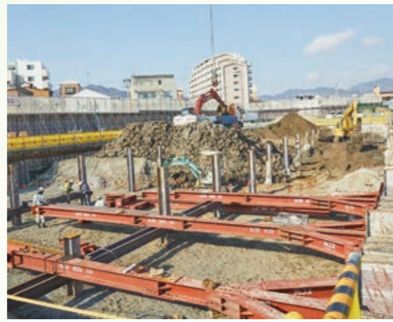
掘削状況(2021年1月中旬時点)
