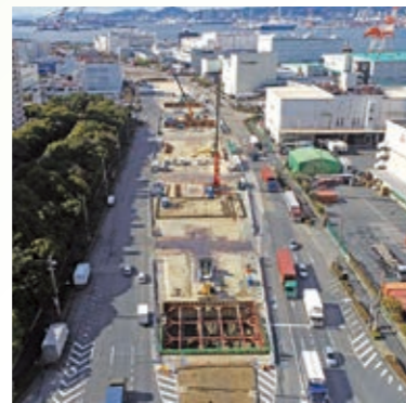
高架橋橋脚工事状況(2021年1月中旬時点)
