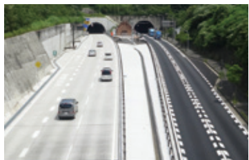
清滝トンネル(大阪側坑口)付近
