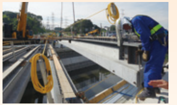
工場で製作した橋げたを大型クレーンで設置中
