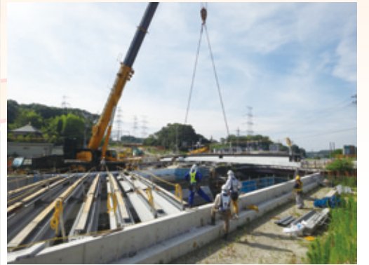
高山大橋架替工事(橋げた架設の様子)
