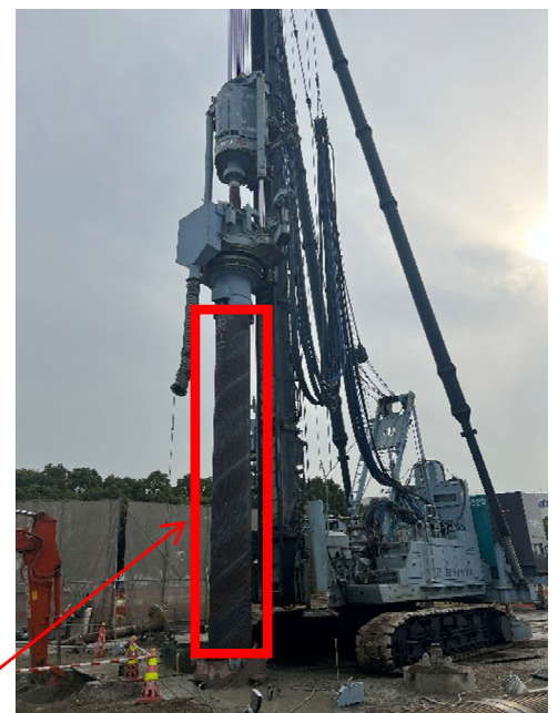
↑ 鋼管杭の打設状況(後日施工)
