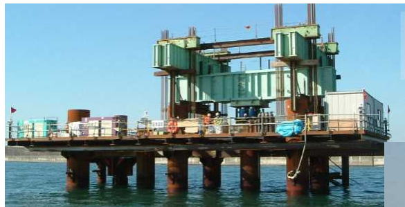
図-1. 国内最大規模の静的載荷試験 (東京ゲートブリッジ: 鋼管杭径1,500mm)
