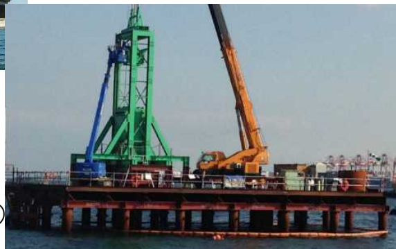
図-2. 国内最大規模の急速載荷試験 (東京港新客船ふ頭: 鋼管杭径2,000mm)
