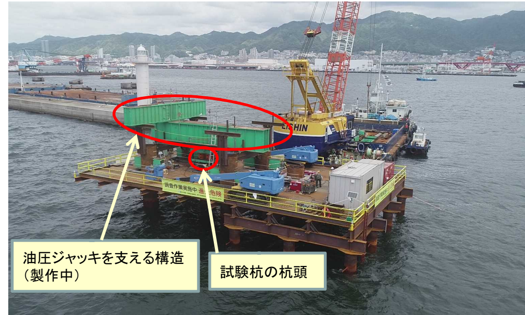
図-5. 杭の鉛直載荷試験(静的載荷試験)準備状況(5月20日現在)
