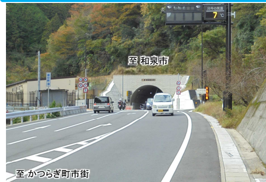
【写真②】鍋谷トンネル南側坑口付近
