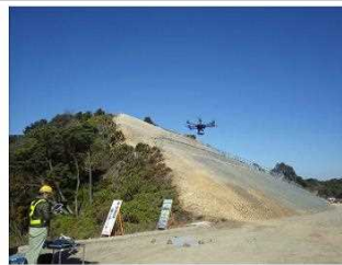
(ドローンによる三次元測量)
