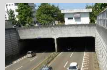
大型ボックスカルバート
