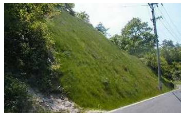
切土（のり面保護）
