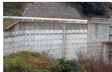
盛土(補強土壁)
