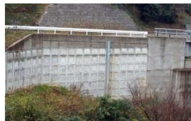
盛土（補強土壁）
