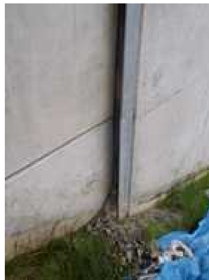
写真 土砂のこぼれ出し例
