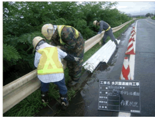
<防護柵の取替>
