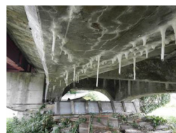
主桁のひびわれ
