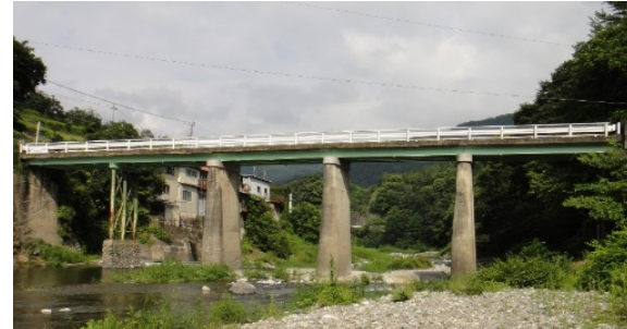
&lt;御鉾橋の状況&gt;
