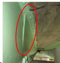
主桁の変形
