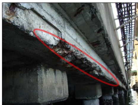
コンクリートの剥離、鉄筋腐食が発生
