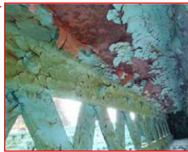
鋼材の腐食
