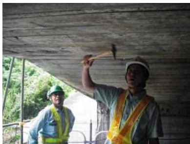
目視及びハンマーによる打音検査
