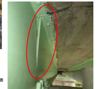
主桁の変形
