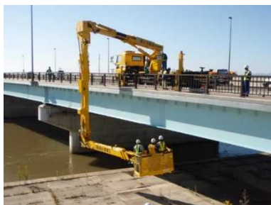
橋梁点検車による点検
