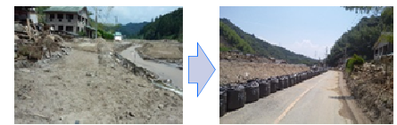
災害時の道路啓開
