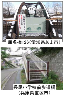
通行止め橋梁
