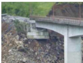
斜面変状による橋台の沈下
