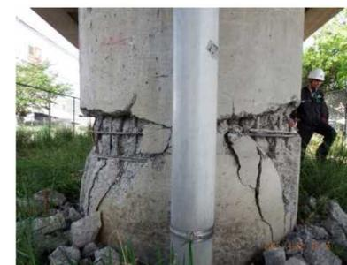
写真-7 段落し部の損傷
