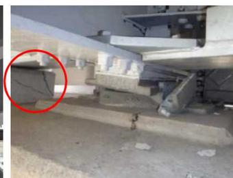
写真-6 支承の破損の状況
