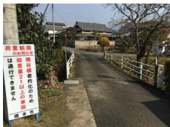
荷重制限 実施状況
