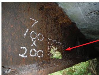
G1桁ウェブ面に孔食
