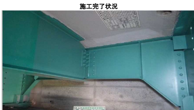
施工完了状況
